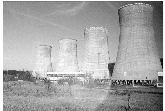
Miesto výstavby tretieho a štvrtého bloku elektrárne. Foto: - ed -
